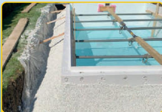
Formung und Verdichtung des eingebrachten Materials
