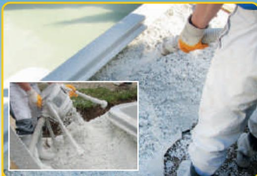
Einbringung der Pooldämmung über das ThermoWhite-Mixmobil
