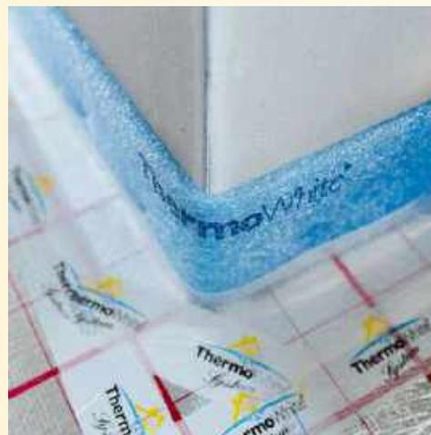
Folienverlegung mit Randdämmstreifen
